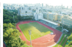
Joint Sports Centre 联校运动中心
